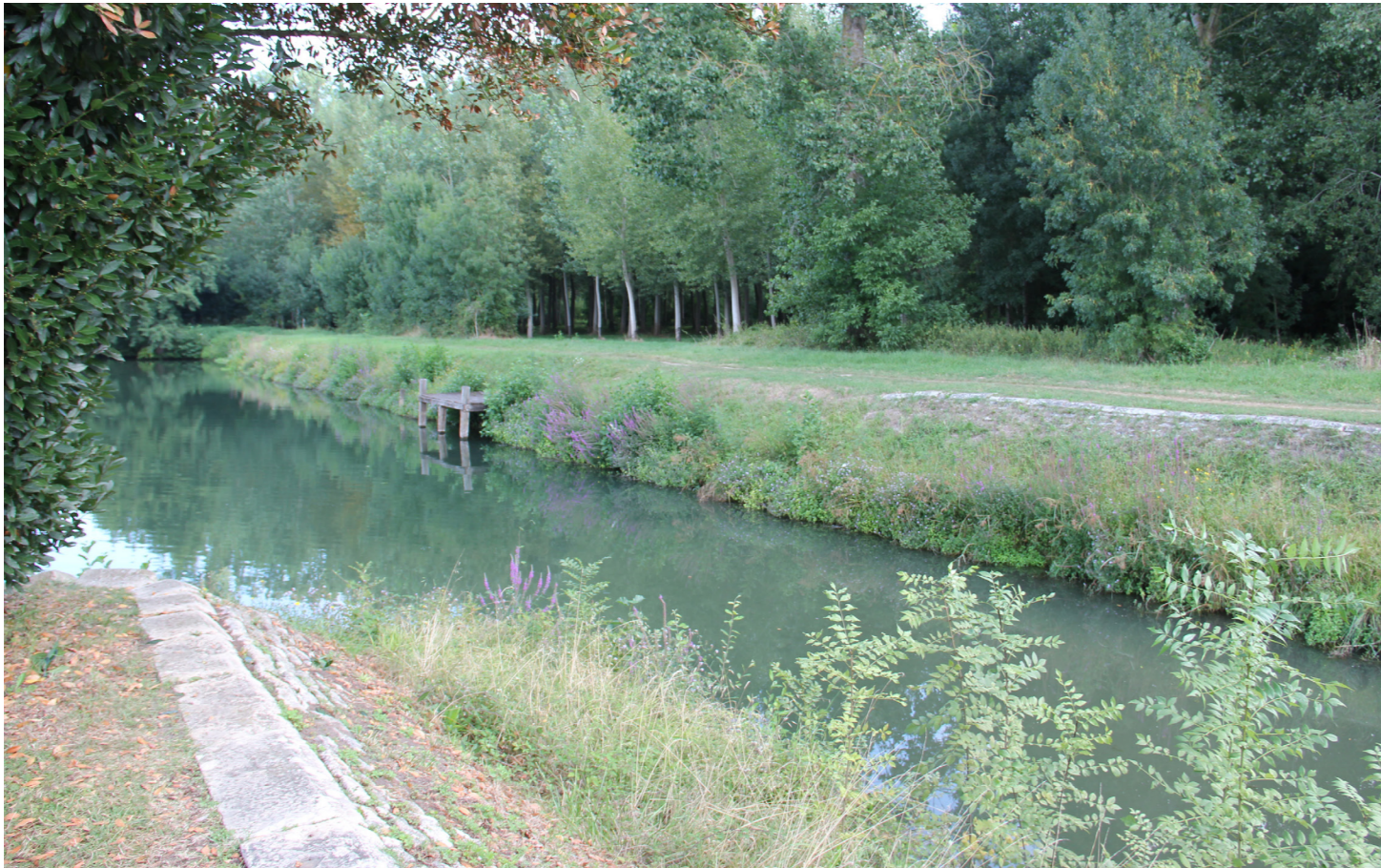
PONTON AVAL : Vue 2 depuis l'ilot de l'écluse (Actuellement)
