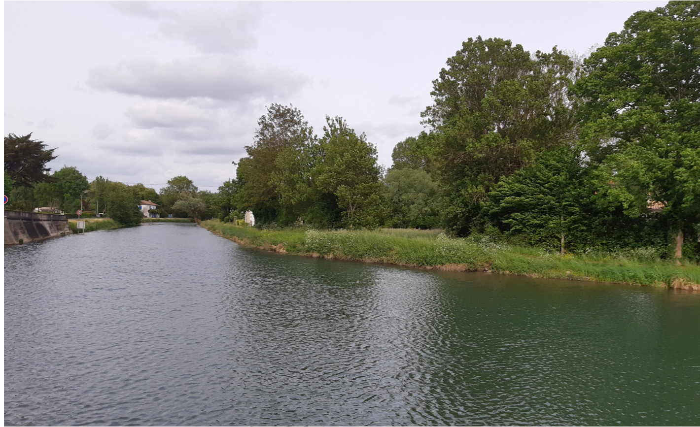
PONTON AMONT : Vue 1 depuis sur la rive gauche (Actuellement)
