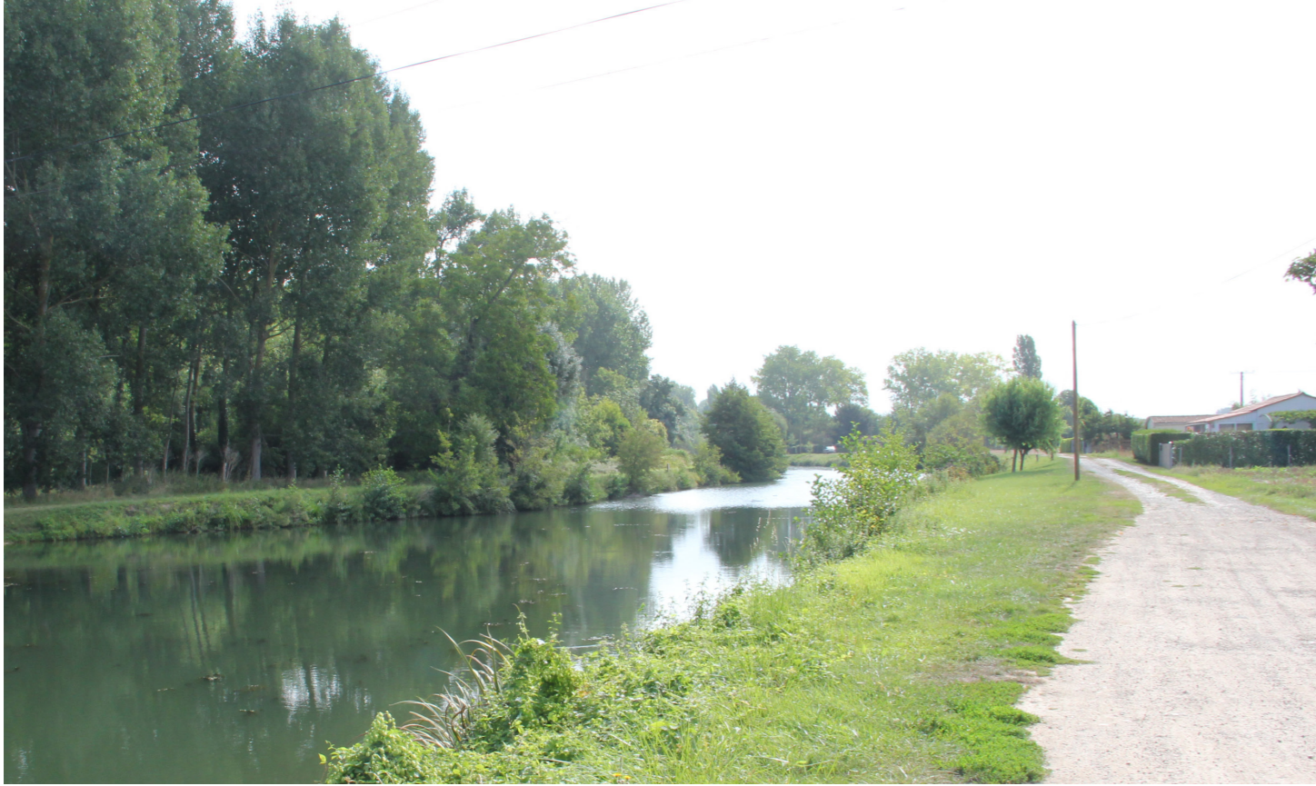
PONTON AMONT : Vue 1 depuis la rive droite (Actuellement)
